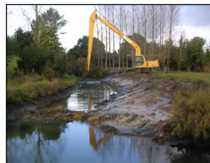
Travaux de curage
